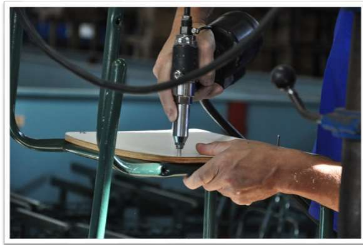
Oficina de reforma de mobiliário escolar
